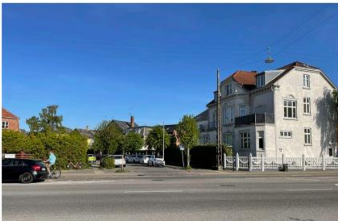
Englandsvej 27 på hjørnet af Søren Norbys Allé. Stor voluminøs villa som genbo til Englandsvej 25. Foto: Lantz Arkitekter.
