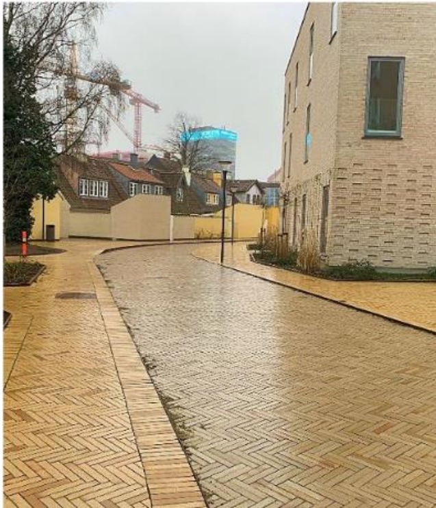
Figur 5: Gul teglstensbelægning i lokalt miljø
