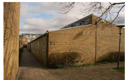
Institutionsbygninger i 1 etage og med forskudte tage
