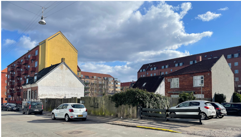
Illustration 4: De tre små villaer på Theklavej understøtter den store variation og diversitet i området, hvor kontrasten mellem det mere klassisk lejlighedsbyggeri og de små punkthuse giver stedet en særlig karakter.
