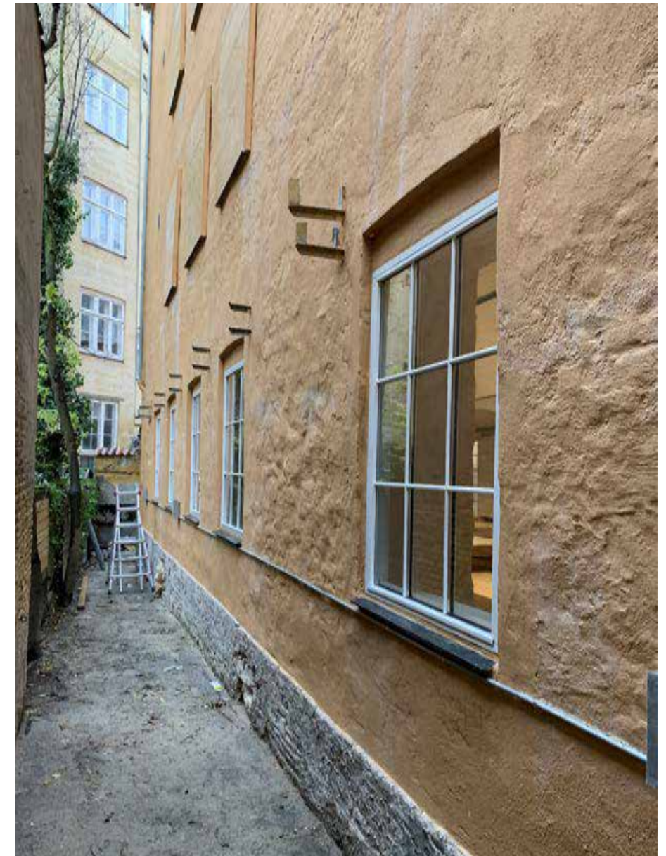
Vinduer på nordfacaden (lukkede fra 1. sal og op)
