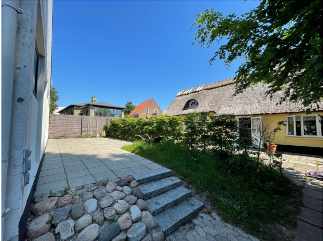
Nuværende erhvervsbygning til venstre med terrasse. Eksisterende stråttækte stuehus med bolig til højre
