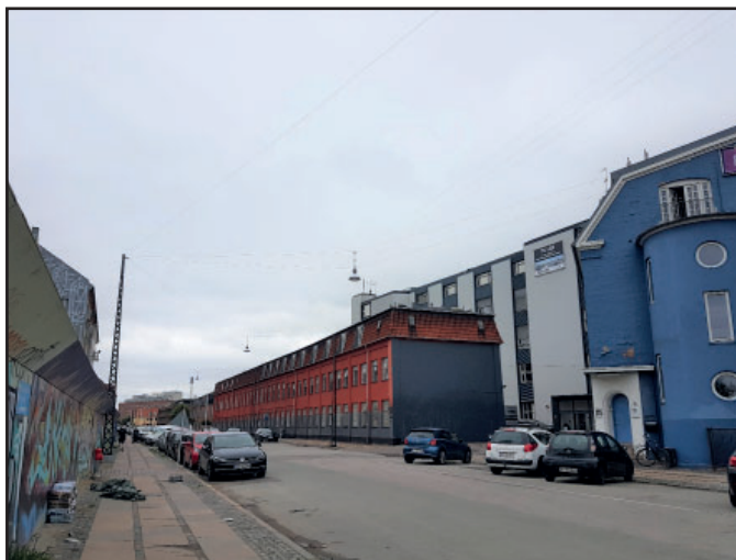
Eksisterende boligbebyggelse set fra Aldersrogade
