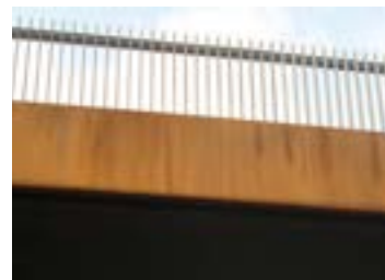
Referencefoto. Langeliniebroen beklædt med rustbrunt cortenstål.
