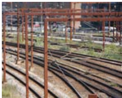
Referencefoto. Rustbrune stålmaster på baneterrænet.
