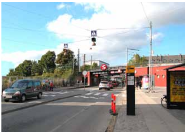
Jernbane Allé med den ubebyggede grund til venstre..
