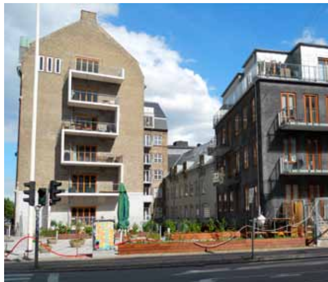
Halmtorvet 29 er ombygget til boliger.
