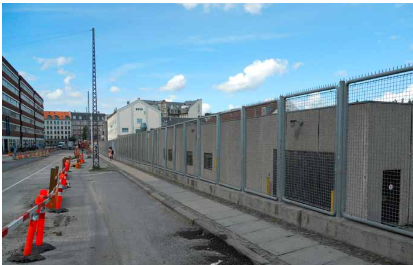
Lokalplanområdet set fra sydlige del af Skelbækgade. Den lave bygning rummer lager. Sammenlign. med projektillustrationen s. 4 øverst
