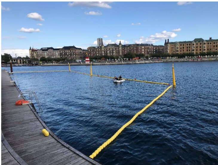
Banetov og markeringsbøje ved badezone Kalvebod Bølge.
