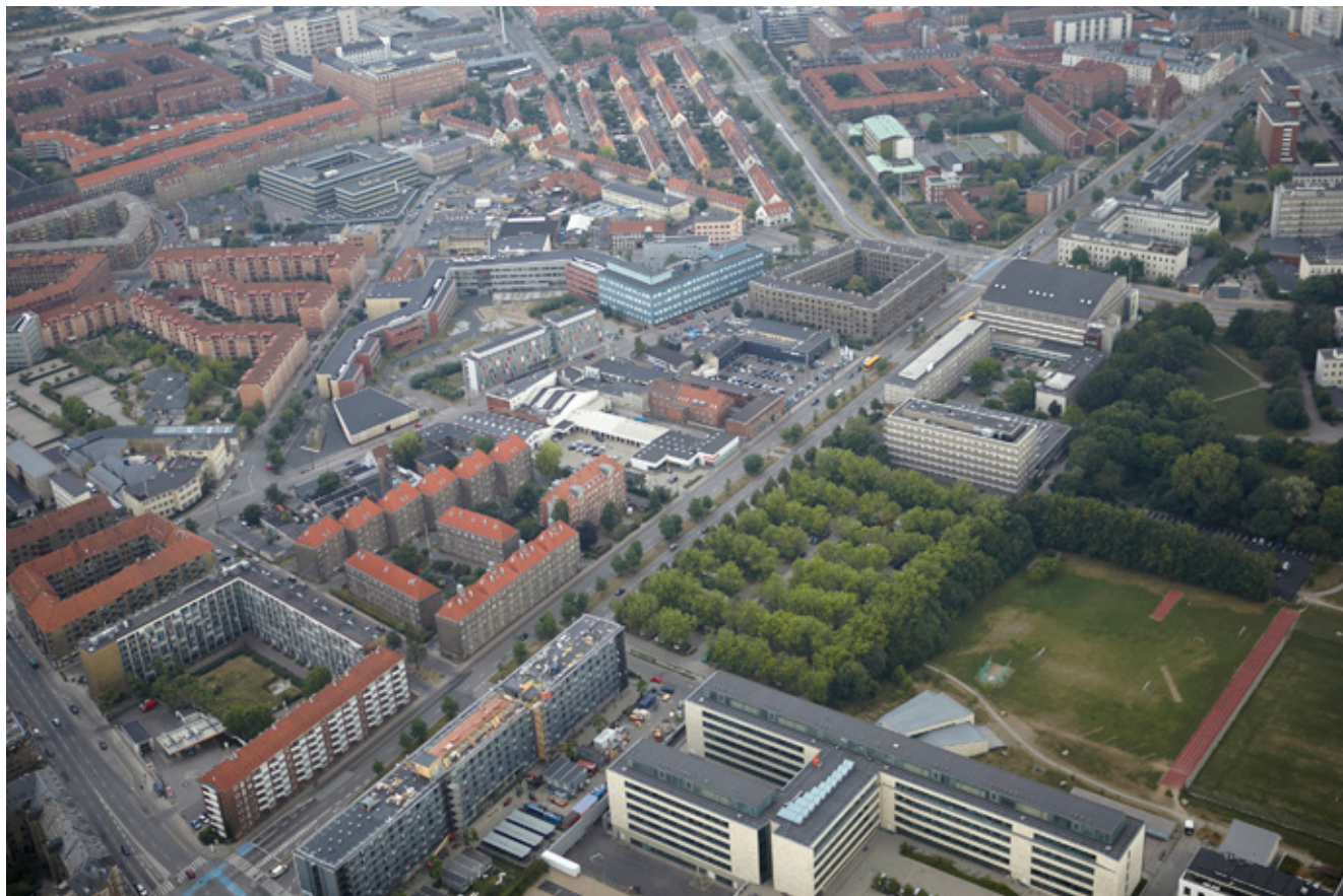
Luftfoto af området set mod nord (JW Luftfoto juli 2010). Den tætte træbeplantning i midten af billedet skjuler den midlertidige parkeringsplads, hvor bygningskompleksets 1. etape opføres.
