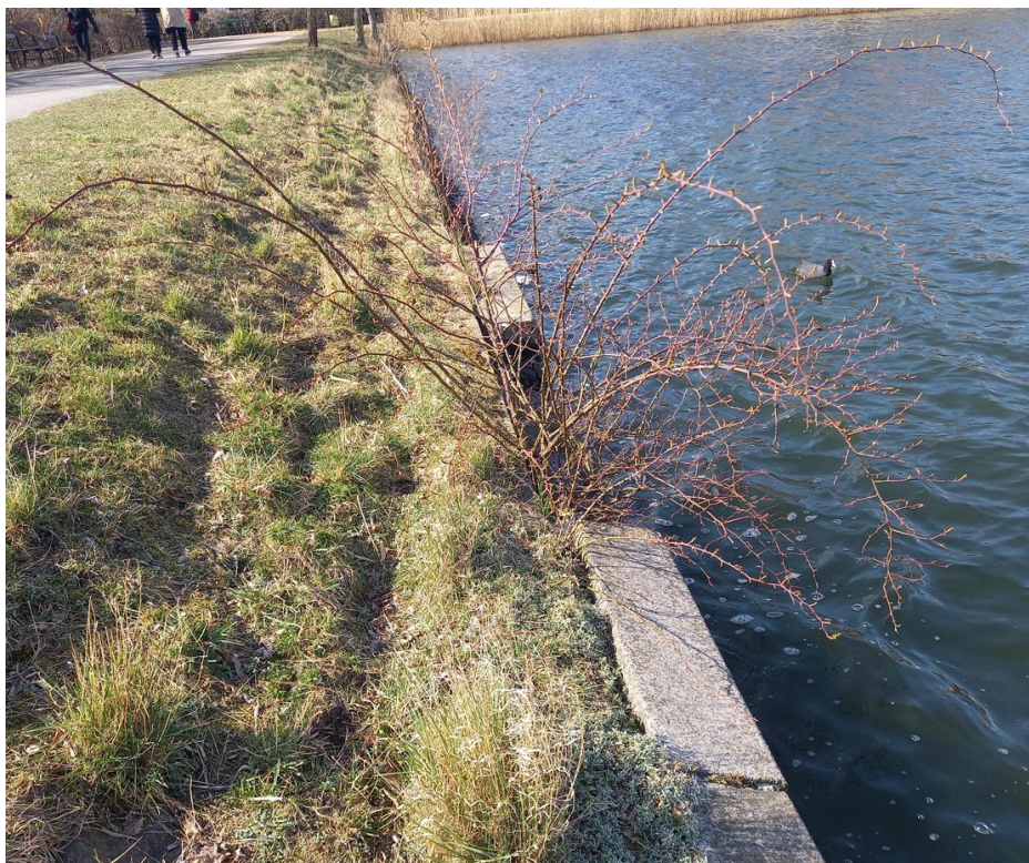
Figur 28: Skråning med overgroet stenglacis og søkant med nedfaldne granitsten. Øverst i billedet anes de selvsåede træer i skråningen bag søkanten. Foto: Artelia.
