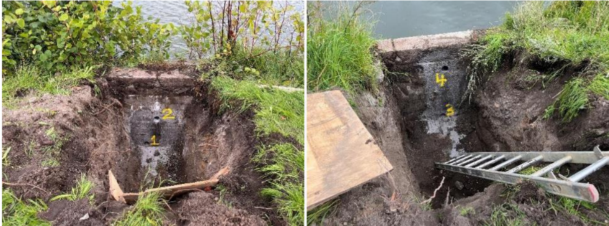
Figur 27: Udgravninger til udtagelse af borekerner. Foto Artelia.
