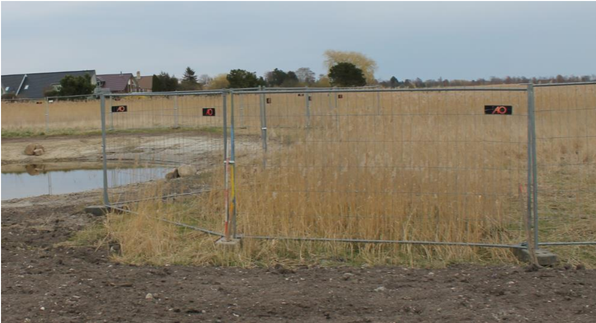
Figur 22: Eksempel på byggepladshegnets udseende. Foto: Artelia.
