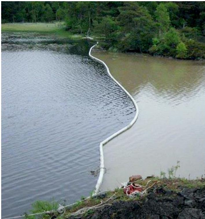
Figur 25: Illustration fra Ahlsell, der viser funktionalitet af en siltbarriere
