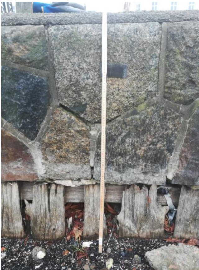
Figur 4: Søkant på del 1 – Ca. 25 cm fri træspuns over søbund, 70 cm kvadersten og 5 cm asfalt. Foto: Artelia.
