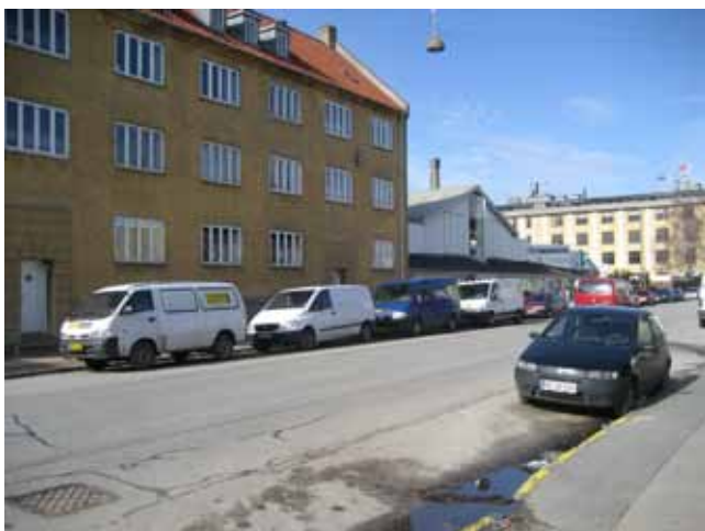
Boligbebyggelse mod Strandlodsvej
