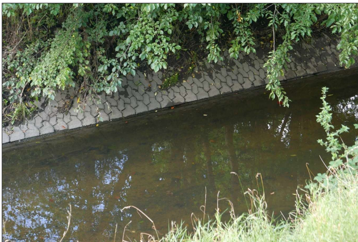
Figur 2-1. Det nuværende kanalagtige forløb med flisebelægning levner ikke mange muligheder for en varieret vandløbsflora og -fauna i Harrestrup Å.
