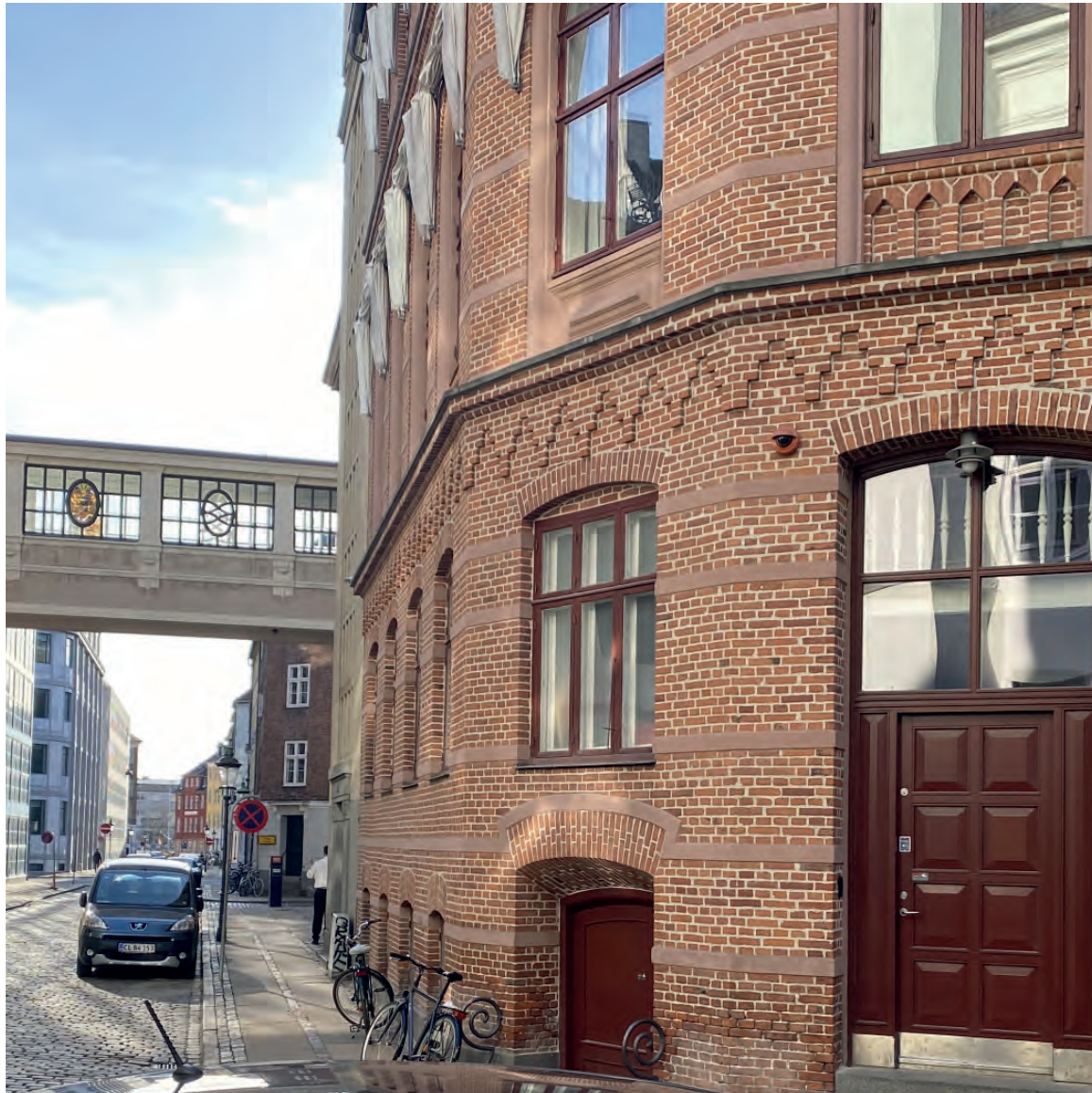
Fotoregistrering Eksisterende forhold
