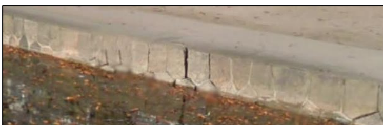
Figur 10. Eksisterende søkant før renovering.
