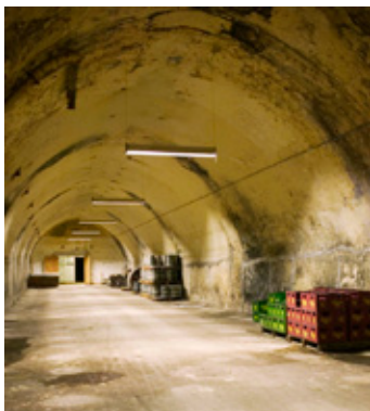
Kælderen under Rød Lagerbygning.
