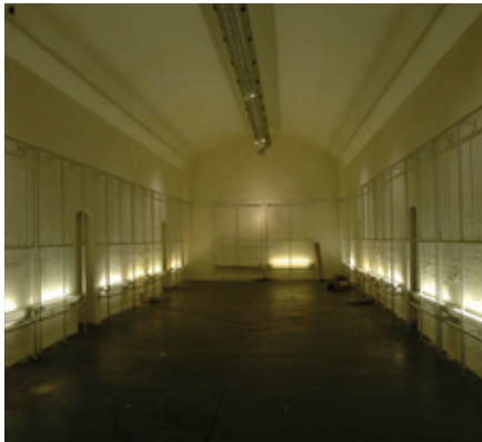
Den eksisterende kælder under pladsen
