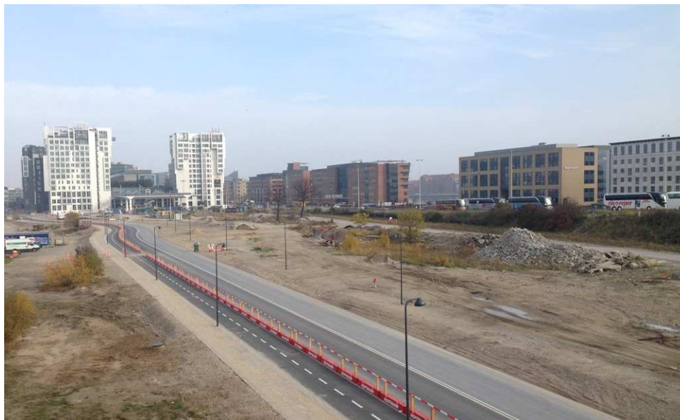
Figur 11-2 Projektområdet henligger primært som en ubevokset grusflade. Den nordlige del af projektområdet ses her til højre for den nyanlagte Carsten Niebuhrs Gade. Foto er taget fra Dybbølsbro november 2015.
