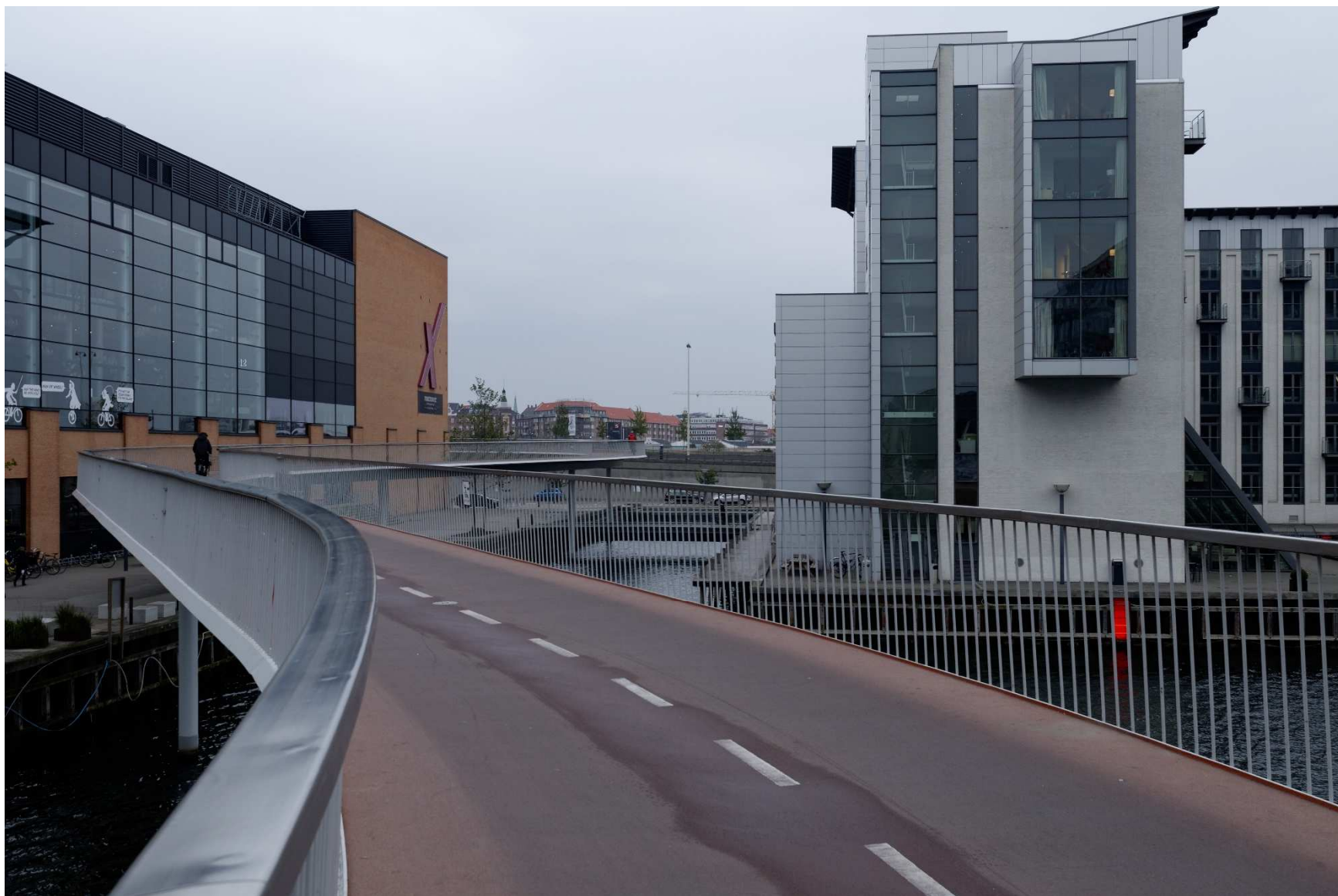
4A. Udsigt fra Cykelslangen mod Dybbølsbro – før
